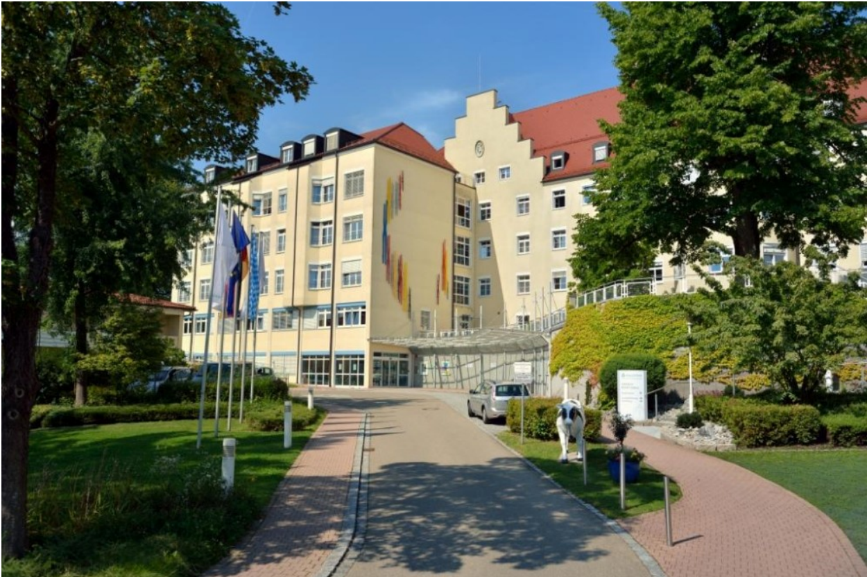
Asklepios Klinik Lindau - Eingangsbereich
